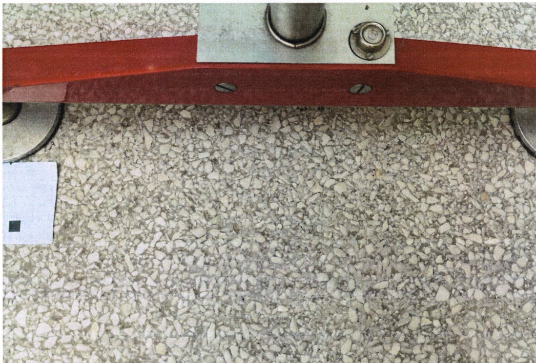
Foto č. 3: Povrch zkušebního místa č. 3
