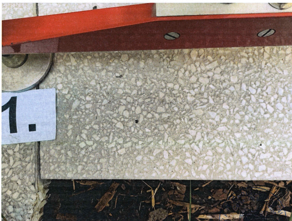
Foto č. 2: Povrch zkušebního místa č. 1
